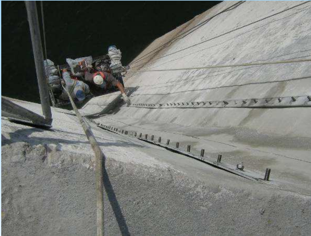
Perfis de fixação da manta colocados
