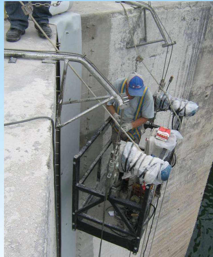
Colocação da manta de base
