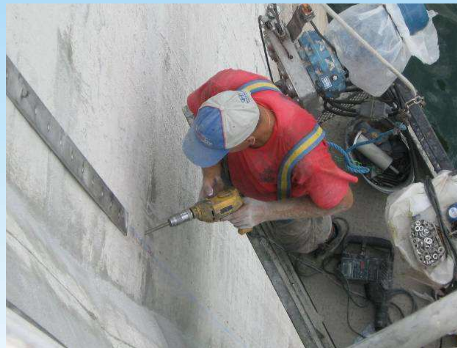
Colocação dos perfis de fixação da manta
