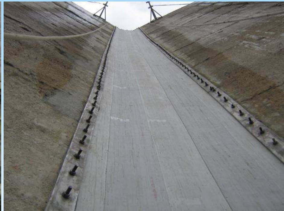
Vista inferior da junta com vedação
