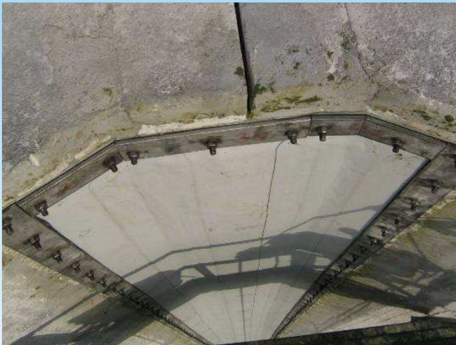
Vista superior da junta com vedação
