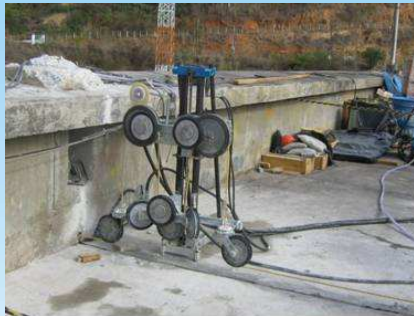
Dispositivo de corte com cabo diamantado
