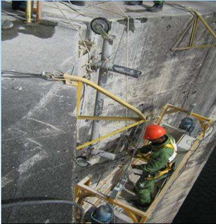
Sistema de direcionamento do cabo diamantado
