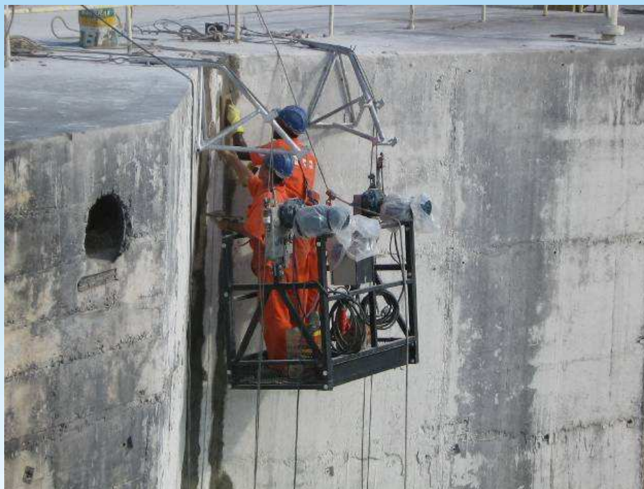
Preparação da superfície do concreto
