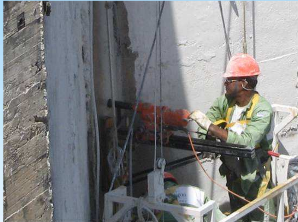
Perfuração de furo piloto horizontal
