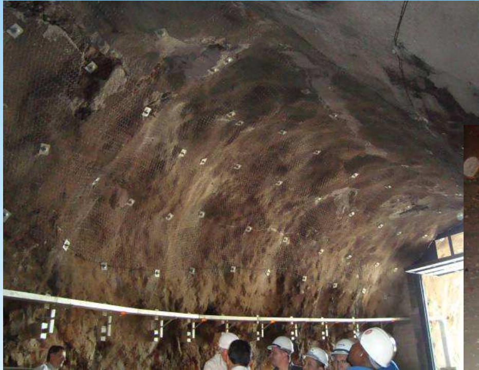
Trecho com tela e chumbadores instalados em Setembro de 2009.
