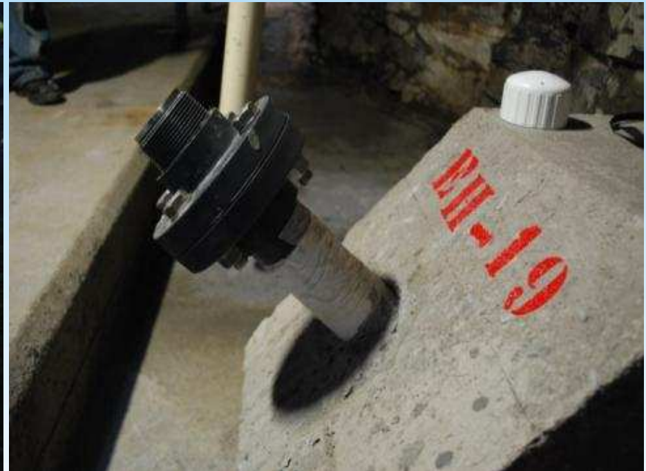
EH-19 no túnel de drenagem.
