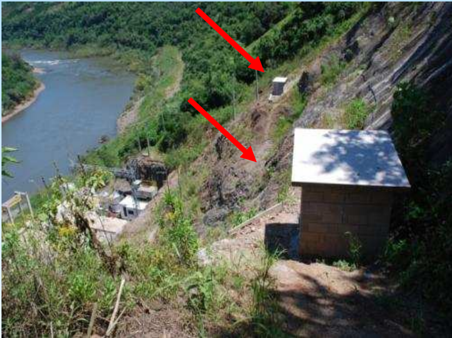
Cabines de leitura.
