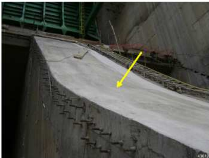
Foto 01 – Detalhe do acabamento da soleira lado esquerdo do bloco 06 camada 15 EJ-B.
