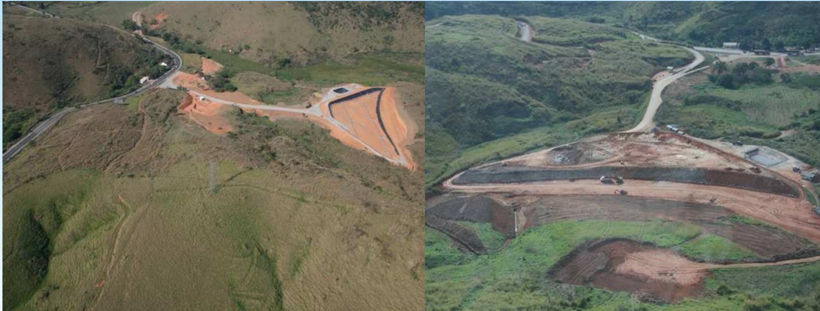
FIGURAS 4 e 5. Aterro Sanitário de Sapucaia, RJ
