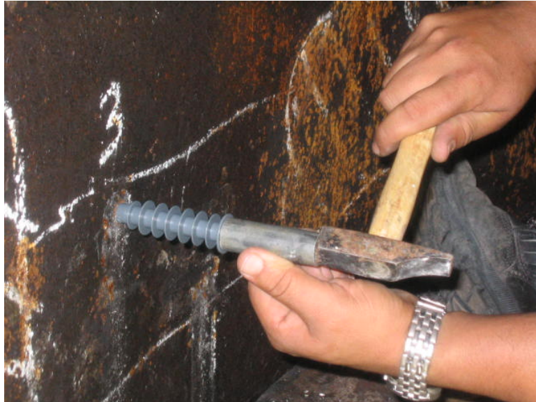
FIGURA 18: Bico sendo fixado no furo de 16mm.
