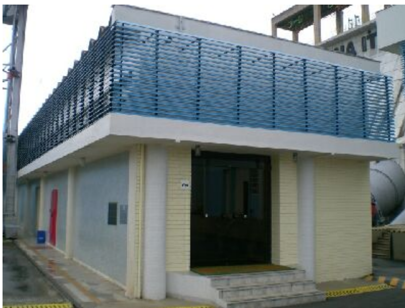
FIGURA 9: Casa de força.
